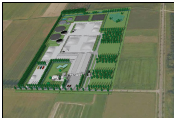
Impressie Biovergassingsinstallatie aan de Veldweg in Haasteeg
